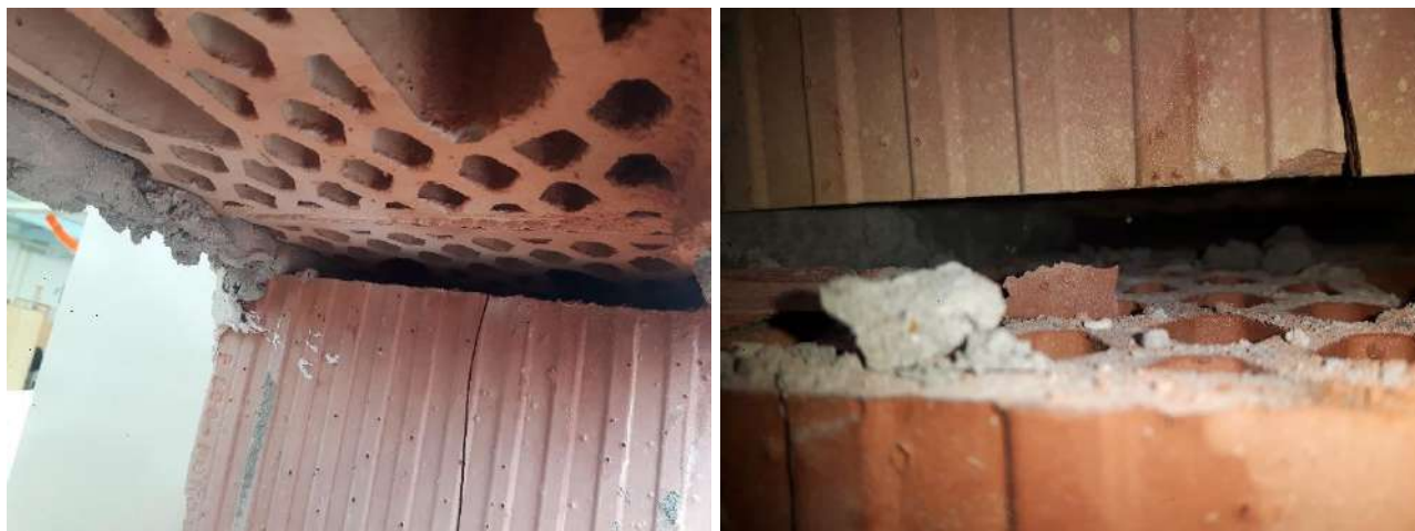
I "corsi" di malta nelle porzioni di muratura a fianco a quella di prova.
