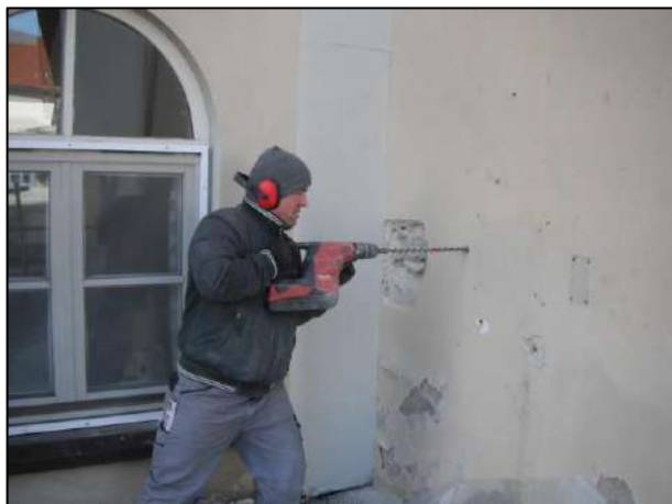
Perforazione per videoispezione e pulizia del foro
