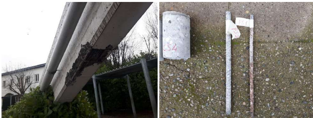
Alcune fasi del prelievo del campione F1 ed i campioni prelevati
