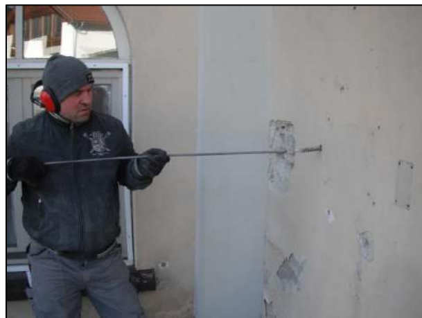
Perforazione per videoispezione e pulizia del foro
