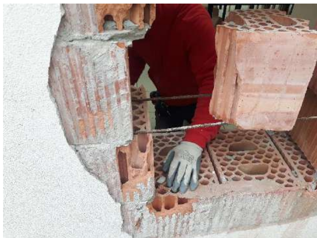
I ferri di armatura all'interno della muratura.
